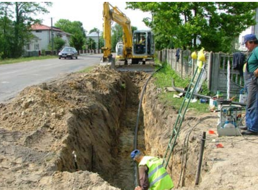
Budowa sieci kanalizacyjnej na terenie gminy Biłgoraj
