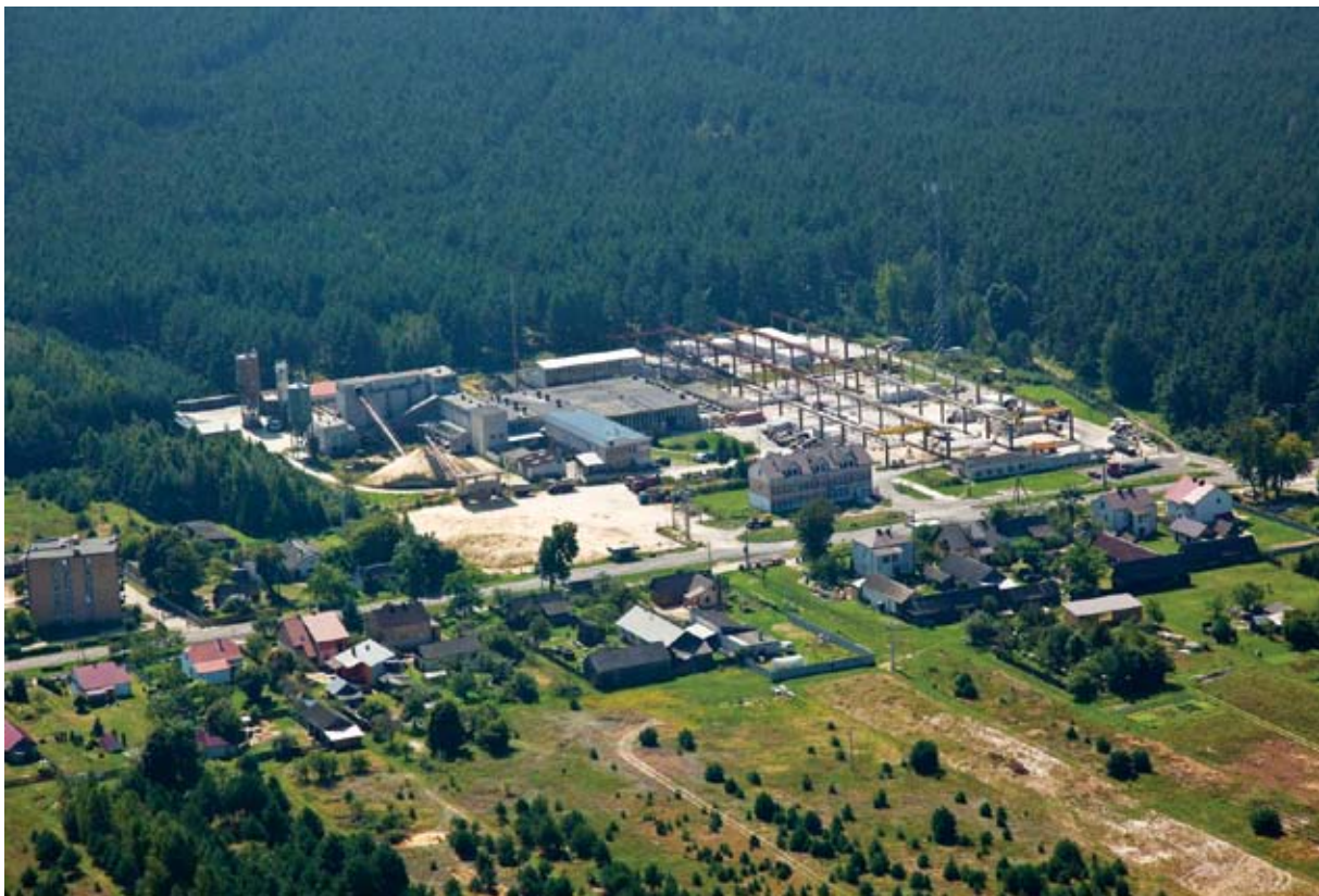
Obszar inwestycyjny Hedwiżyn z Zakładem Wapienno – Piaskowym MEGOLA
