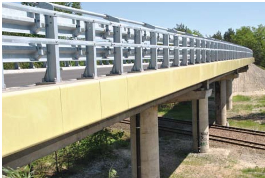
Przebudowany wiadukt w miejscowości Ciosmy
