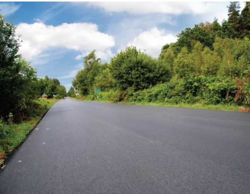
Zmodernizowana droga Korytków Duży – Bukowa
